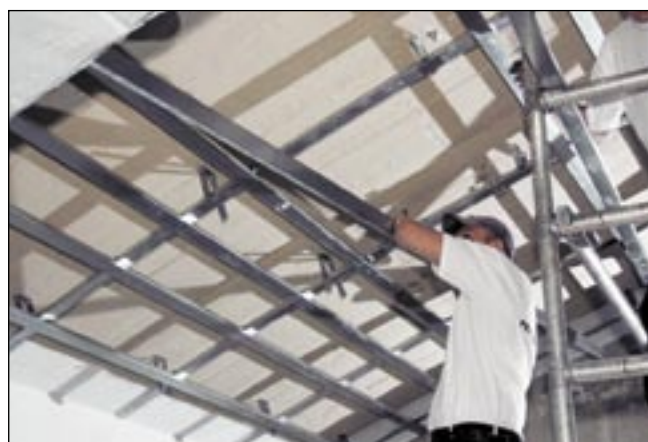
Окачен таван с радиус на закръгление 20 m, изпълнен с плочи Кнауф Cleaneo върху Кнауф CD профили. Технологията на работа не се отличава от монтирането на обикновени акустични плочи
